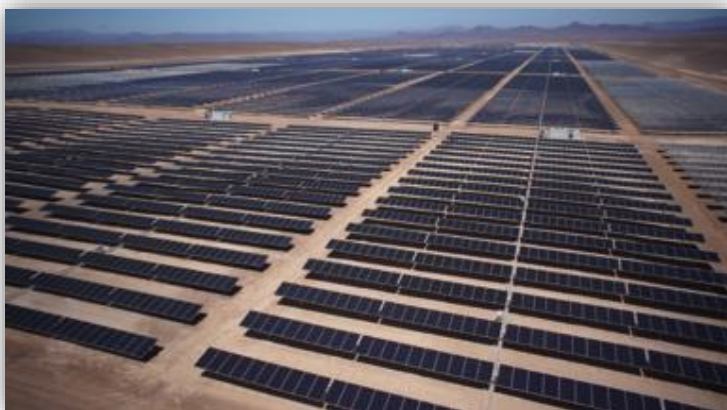
Atacama, Chile – 70 MW Salvador
