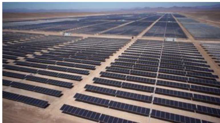
Atacama, Chile – 70 MW Salvador
