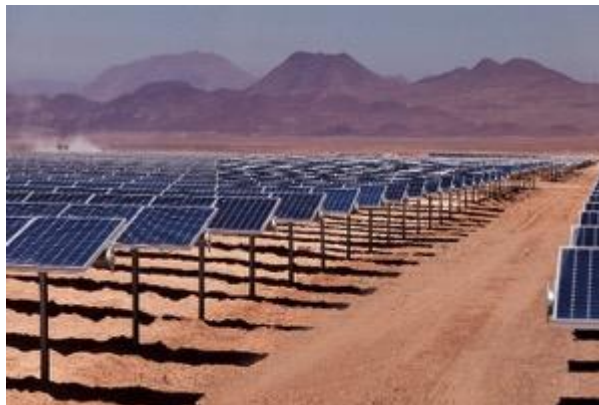
Atacama, Chile – 70 MW Salvador
