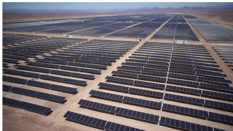
Atacama, Chile – 70 MW Salvador
